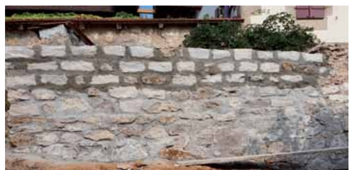
Riss in der Mauer zum Pfarrhaus wurde gerichtet
